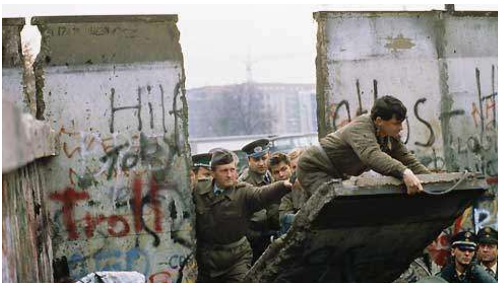
Photo montrant la chute d'un pan du Mur
