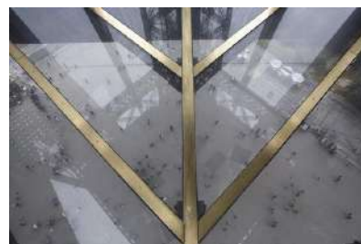
Vue depuis le 1er étage rénové
